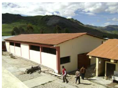
Sala de Usos Múltiples de la I.E.22006
