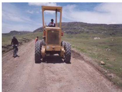
Mantenimiento Rutinario Carretera Cunyac, Pucapampa, Paucará
