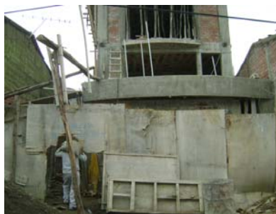
Construcción CEPRO Gil Rivera Plaza
