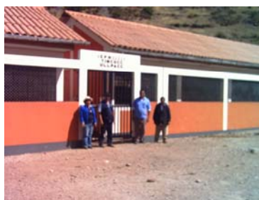
Construc. I.E. N° 22223 Tintocc Ullpac
