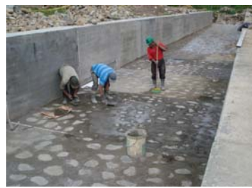
Colocado de base de canal Millpo Pampa Py Canalización Rio Colcabamba
