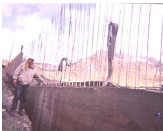
Muro de concreto S.Riego Churcampa La Merced Mayocc I Etapa
