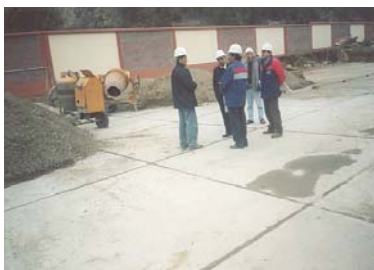
Muro perimetral del CE L.V.Ayacucho
